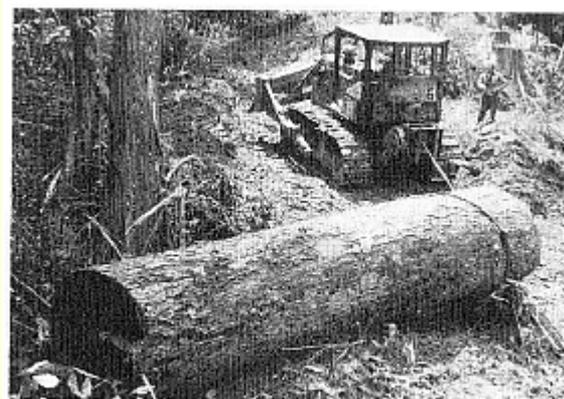
図 14-6 ブルドーザによる集材
